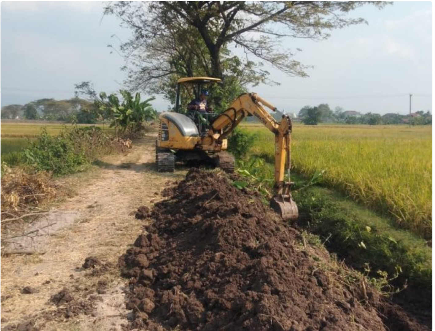
Alat Berat Diturunkan, Guna Kelancaran Pembuatan Talud Sasaran TMMD Reg 121
